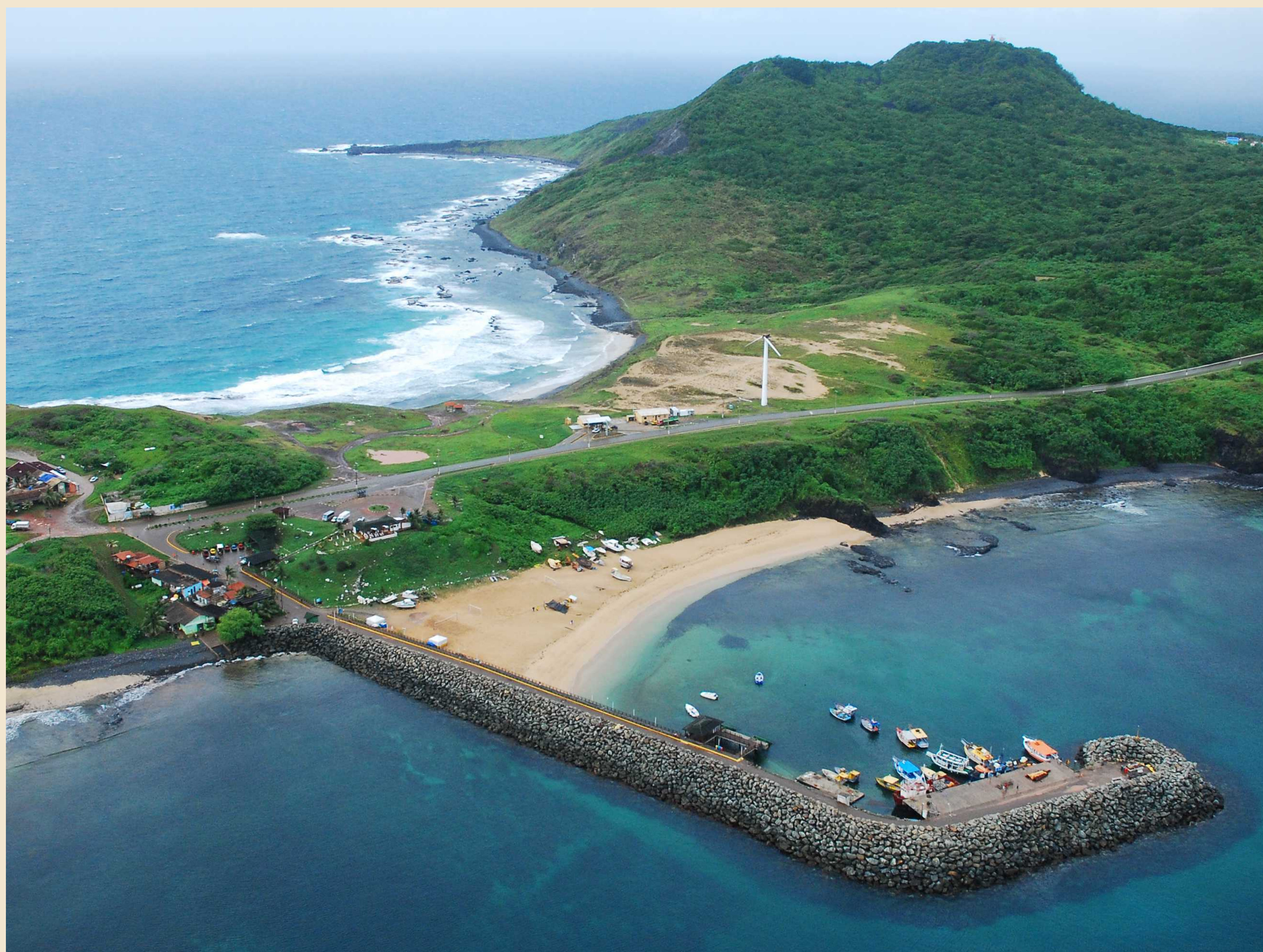
Porto de Santo Antônio. Molhe construído a partir de 1987, com pedras obtidas da dinamitação do Morro Boa Vista. Favorece a economia insular, servindo ao ecoturismo (sobretudo para as atividades náuticas) e ao necessário abastecimento da população.
