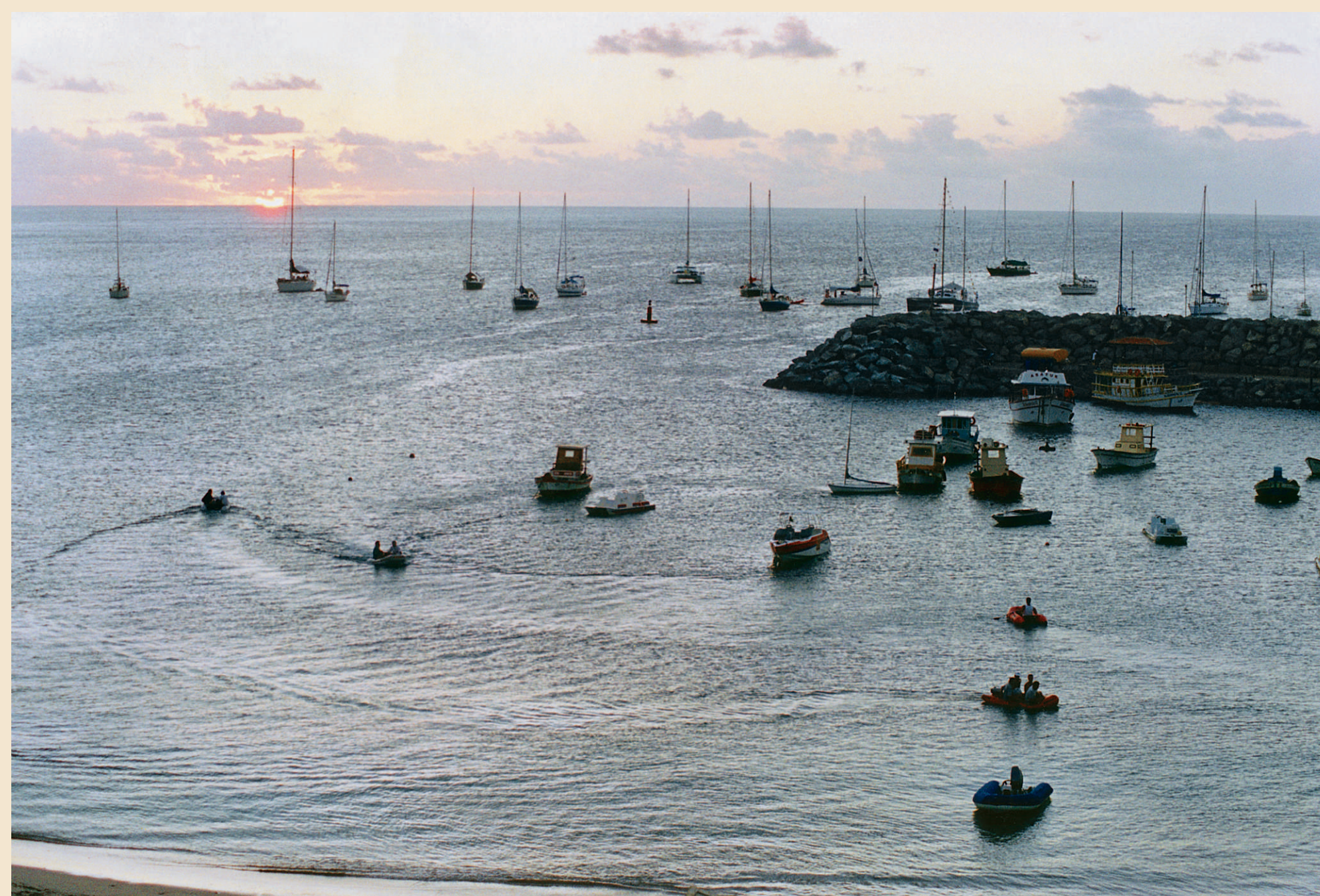
Molhe no Porto de Sto. Antônio, construído em 1987, no governo civil do TFFN.
