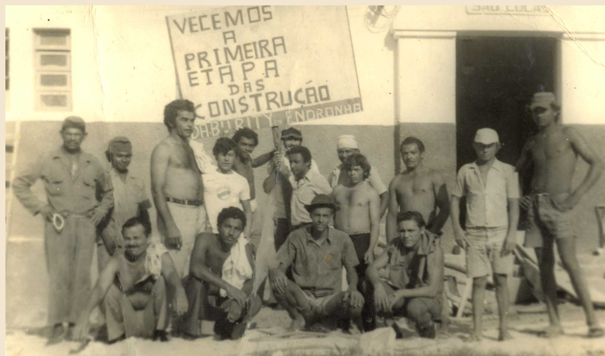
Conclusão da 1ª etapa da construção do Hospital São Lucas, ampliando o antigo Lactário. 1973.
