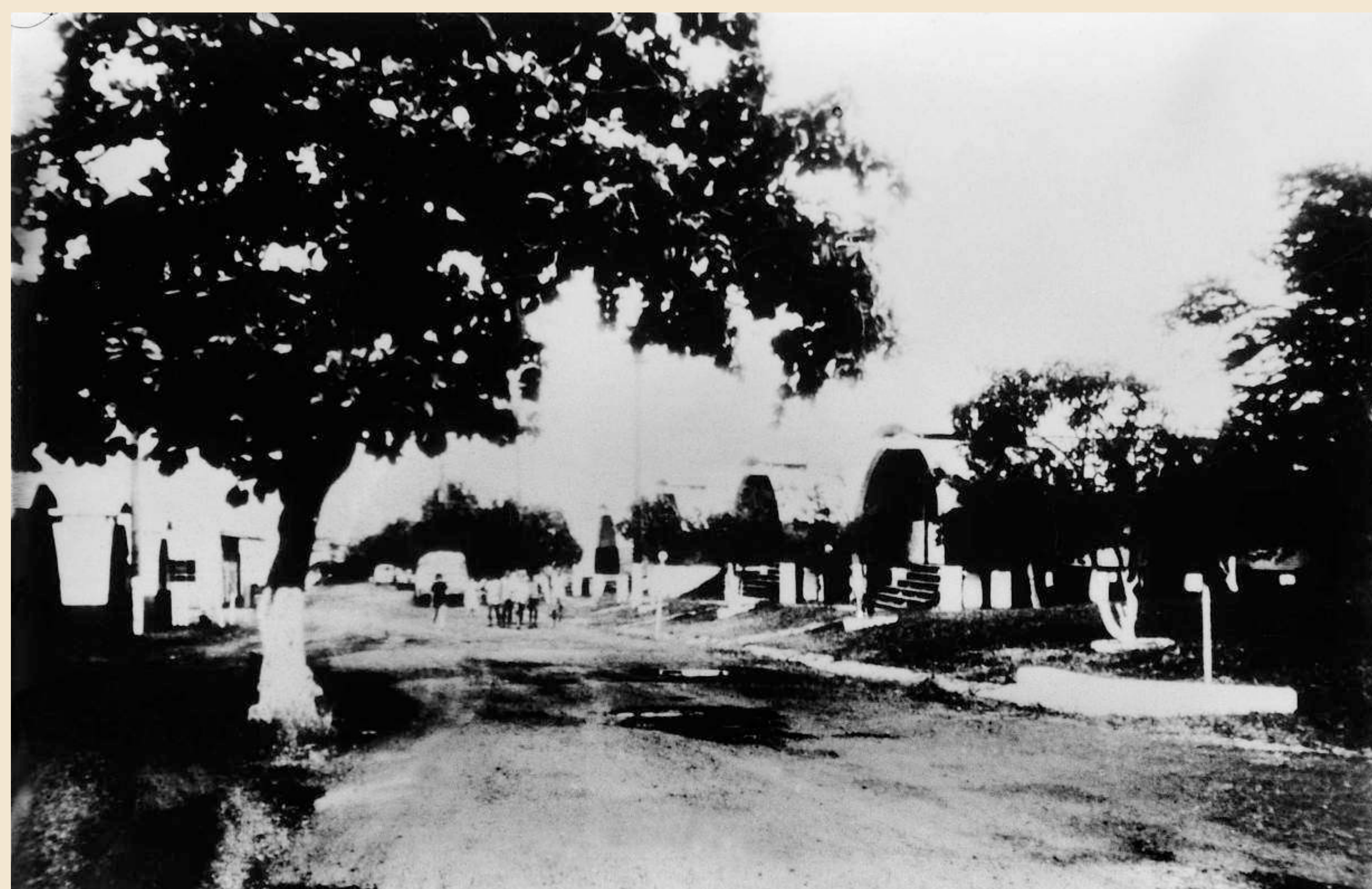
Posto de Observação de Teleguiados.
