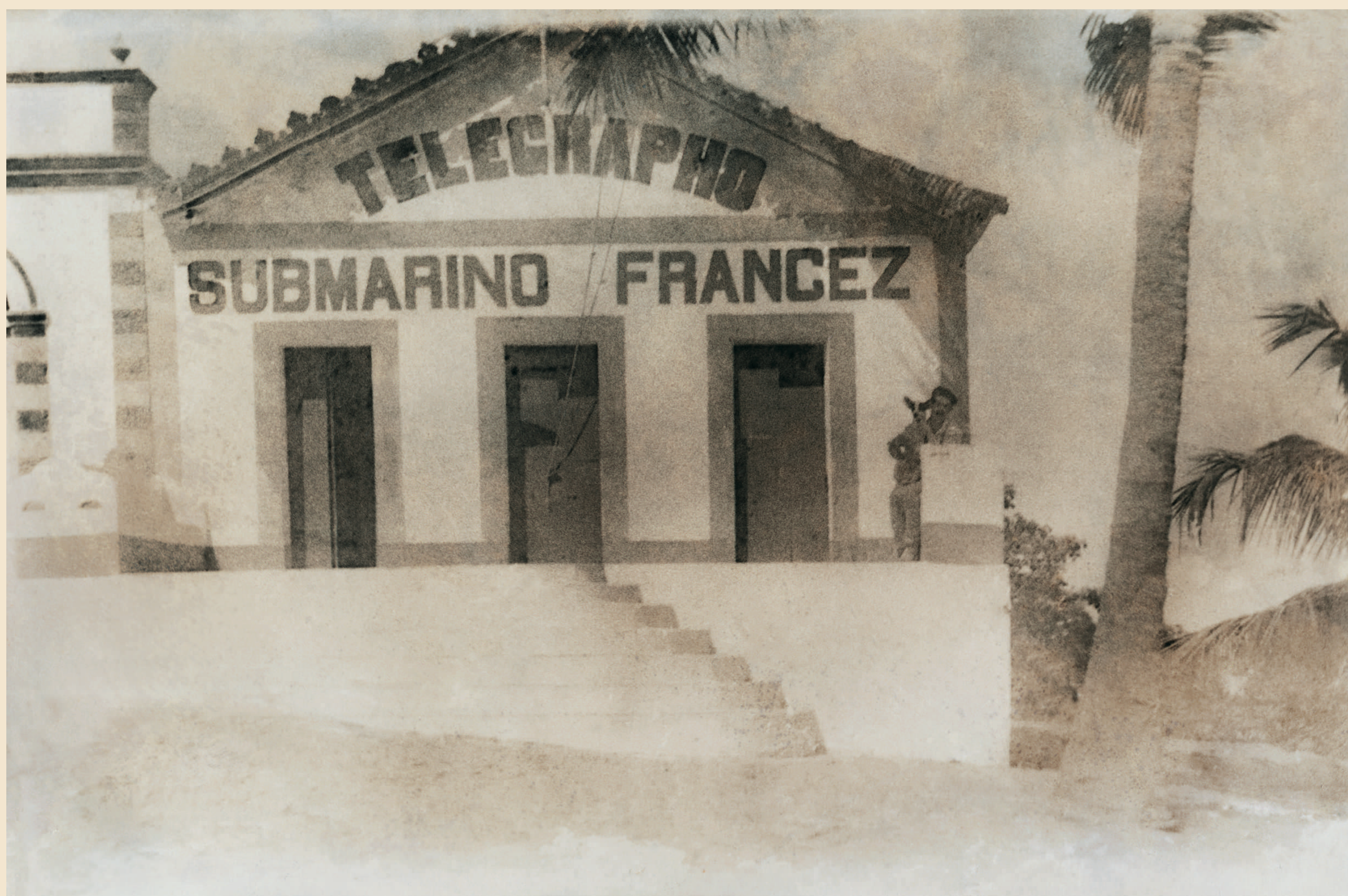
"Chalé" onde funcionou o Cabo Francês, a partir de 1914, localizado ao lado da Aldeia de Sentenciados/ Presídio Feminino, na Vila dos Remédios.
