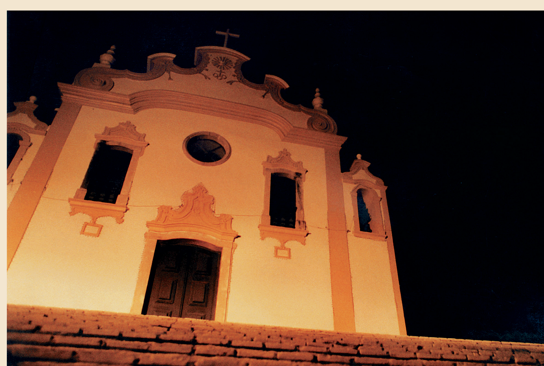
Igreja de N. Sra. dos Remédios - 1988 - após a restauração.
