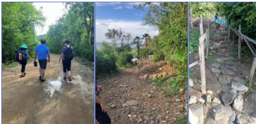
Figura 4-69: Infraestrutura precária de acesso à Italcable e à faixa de praia.
