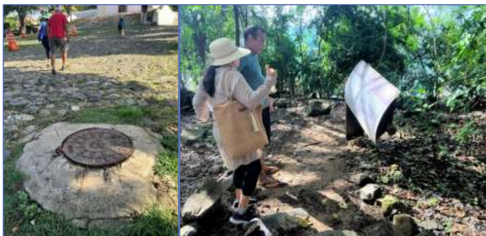
Figura 4-63: Visualização de problemas na rede de esgotamento e de manutenção do patrimônio da orla do trecho 2.1.
