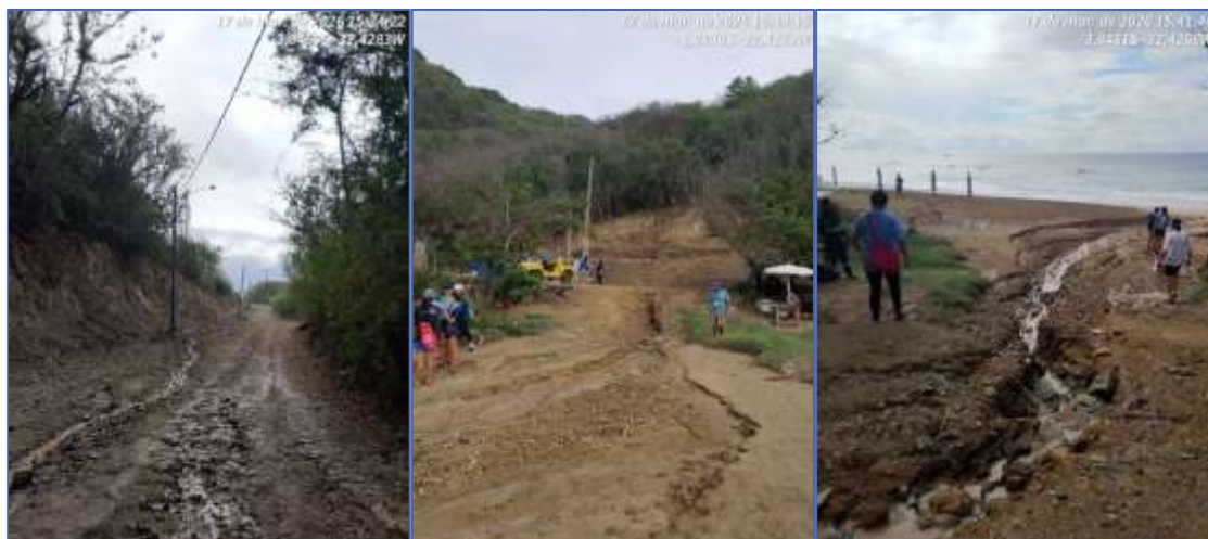
Figura 4-82: Carreamento de solo decorrente de intervenção em via, impactando a faixa de praia e áreas de nidificação de tartarugas.
